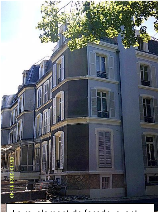
Le ravalement de façade, avant côté gauche, après côté droit.
